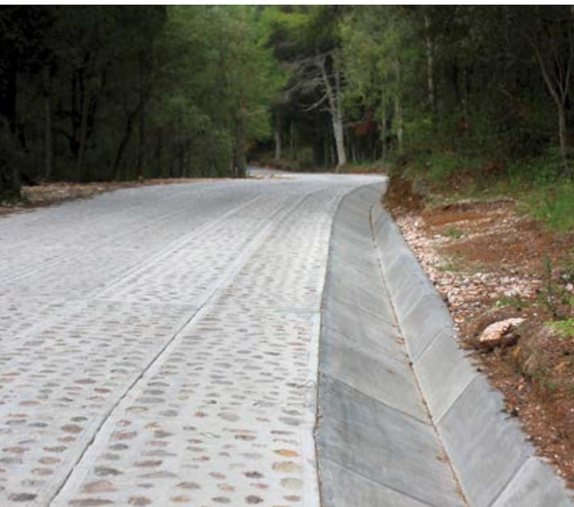
Se llevó a cabo la ampliación de siete a once m la superficie de rodamiento en 8.5 km de la Carretera Estatal 300 Amealco-San Juan del Río. La obra incluyó dos carriles de 3.5 m cada uno, acotamientos de dos m a cada lado para rebase, estructura de pavimento asfáltico, construcción de obras pluviales y la colocación de señalamiento horizontal y vertical. Con esta obra se benefician 7,670 usuarios.
